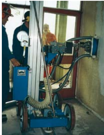
Emissionsfreier Abtrag PCB-kontaminierter Putze
