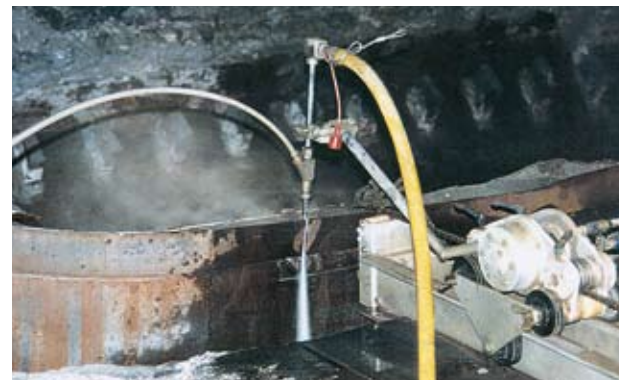
Zerlegen einer kontaminierten Stahlblechwanne mit abrasiven Wasserstrahlen
