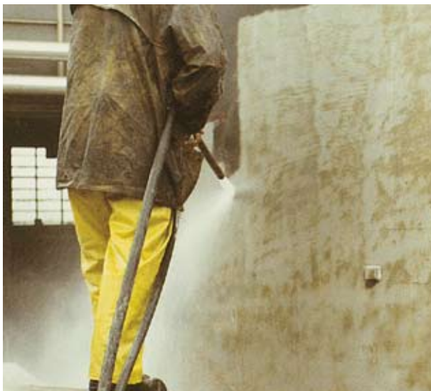
Abtrag von Chromoxid an Hitzeschilden eines Kernkraftwerkes
