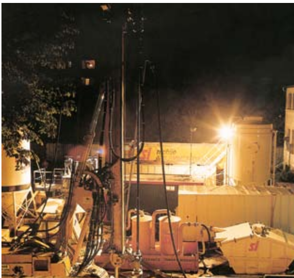
Dekontaminierung Phenol-verschmutzter Böden mit WOMA-Hochdruck-Technik
